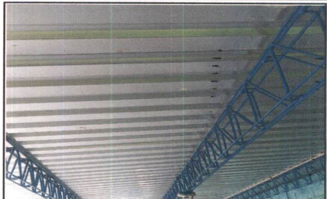
Foto 2: MEJORAMIENTO DE ESTRUCTURA DE TECHO TIPO PORTICO
